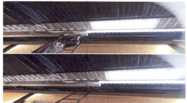
Foto 10: Sustitución de canal de metal por canales de lamina aluzinc calibre 24 con sujetadores
