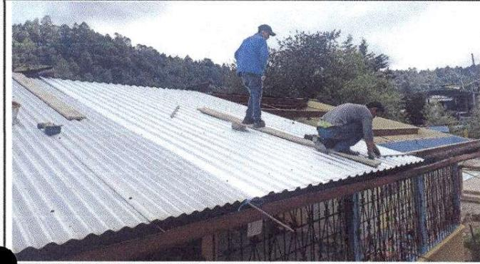
Foto 1: Sustitucion de lamina troquelada calibre 26 por lamina acanalada
