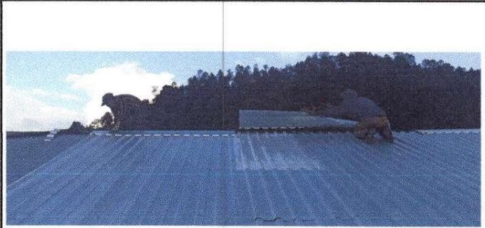
Foto 2: Sustitucion de Capotes por capotes de lamina aluzinc
