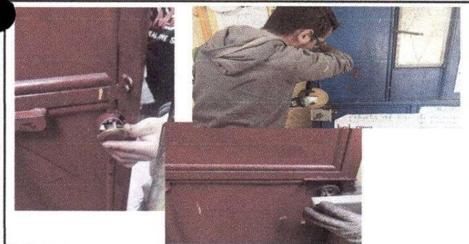
Foto 5: Sustitución de Chapas que estan descompuestas
