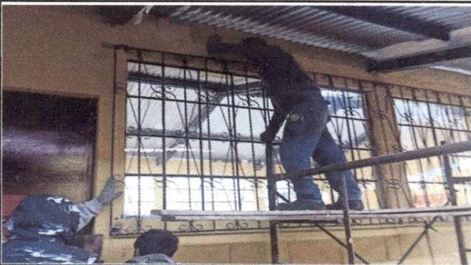
Foto 15: Fabricación e instalación de balcones para protección del aula
